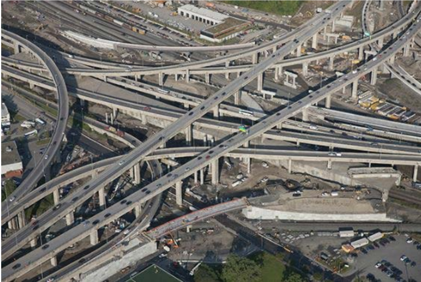
Une infrastructure routière (Échangeur Turcotte): 3,67 milliards de $
